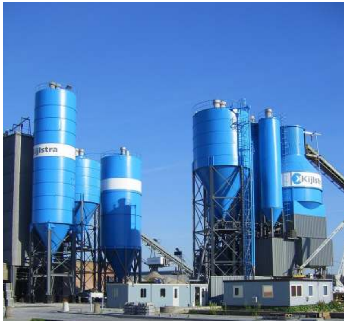
Centrale voor transportbeton en betonproducten
